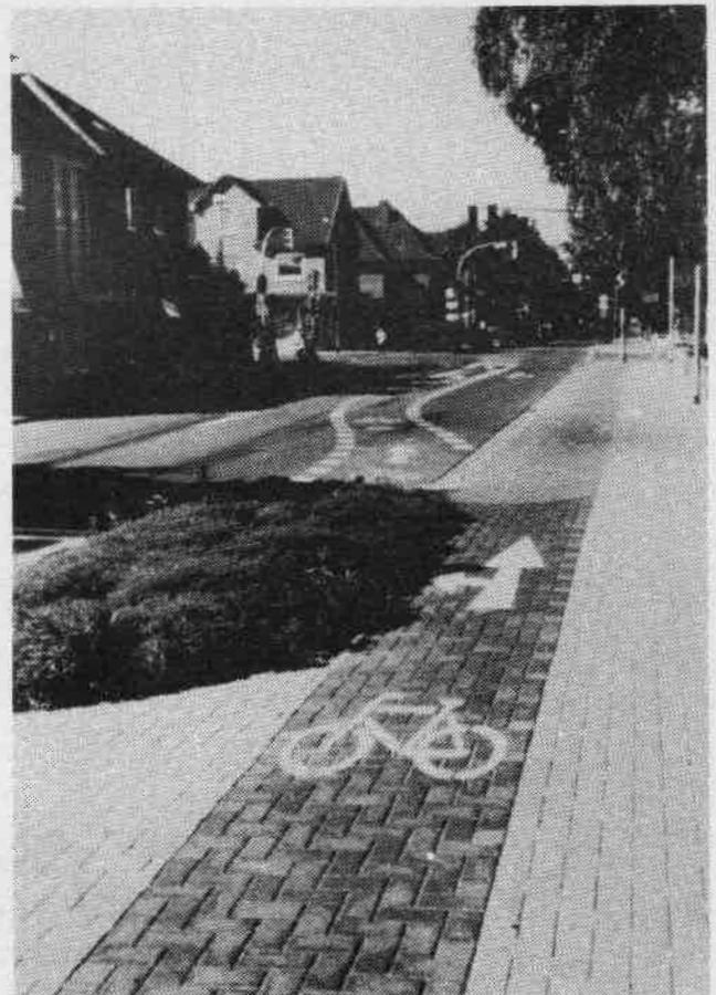
Abb.14: Linksabbiegestreifen für Fahrradfahrer an lichtsignalgesteuerter Kreuzung
